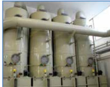
Absorptionskolonne 4-stufig für HF Reinigung
